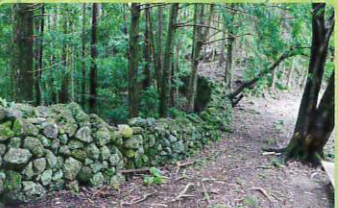
猪垣…農作物を守るための、総延長2.2キロの石積みの垣。宝暦14年(1764)に造られました。
